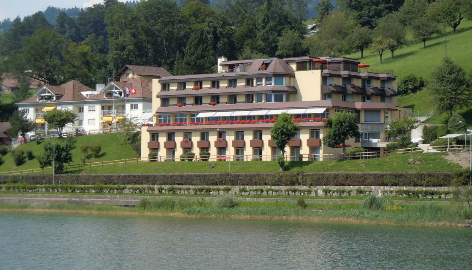
Pflegeheim «Zentrum Breiten», Oberägeri
